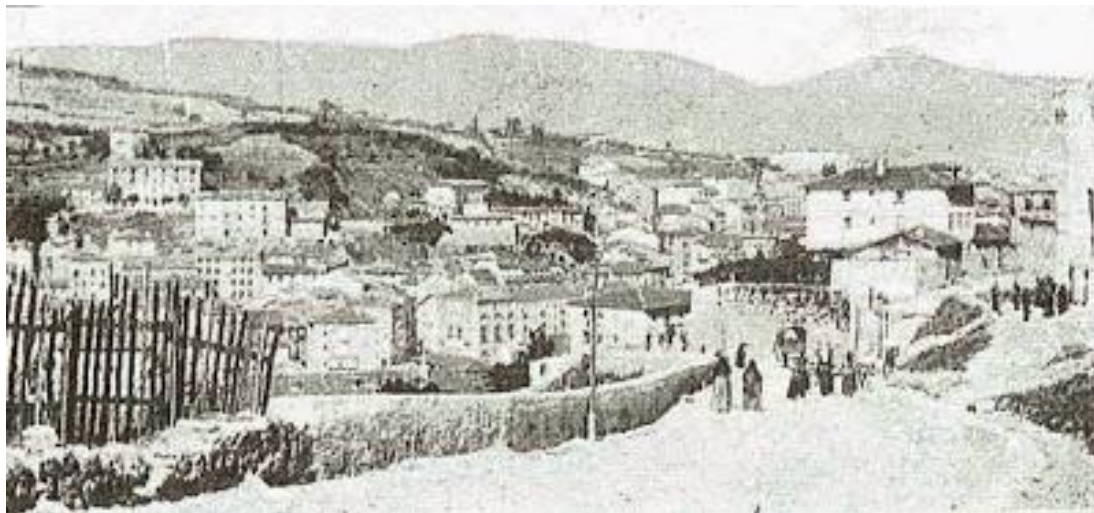
Figura 2 Año 1902, entrada a Bilbao hacia la calle Atxuri
