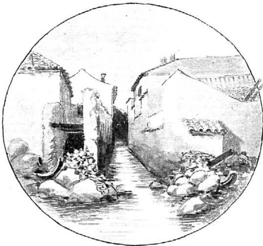
DAÑOS CAUSADOS POR EL TEMPORAL EN LAS BODEGAS DE D. JOSÉ AMUNÁTEGUI.
